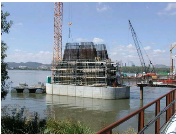
Figura 31 - Pilar em construção
