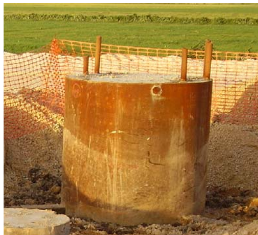
Figura 25 – Tubos de ensaio “cross hole”
