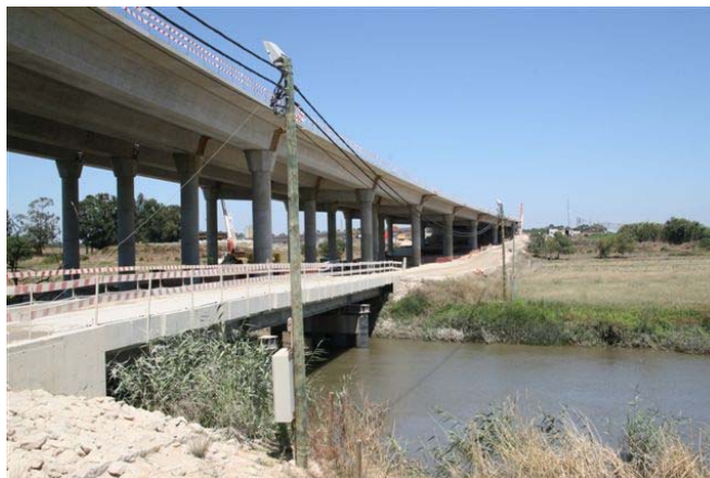
Figura 10 – Caminho paralelo. Pontão provisório (foto)
